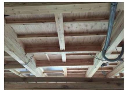
・壁や天井の隙間、割れ 下地材として石膏ボードが入っています。これは石膏ボード用に組んだ木材（間柱・野縁など）に貼っており、木材が伸縮するとボードもあわせて動きます。そのためボードの継ぎ目が隙間や割れとなって現れる場合があります。乾燥する冬場に隙間が広がるなどの現象も見られますが、表面上のもので建物の強度に影響はありません。
