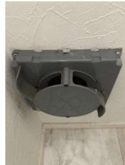
給気口＝基本的に常時開放してください。閉じていると換気扇を回してもうまく空気の流れができず、換気不足や結露の原因になります。フィルターはホコリが詰まったら清掃または交換をお願いします。
